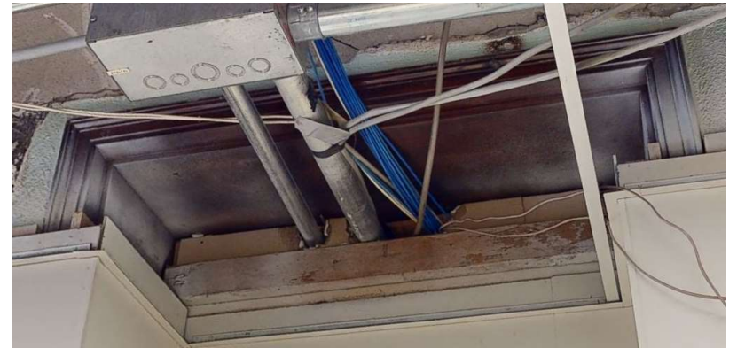
Existing door trim above ceiling plenum - 2023
